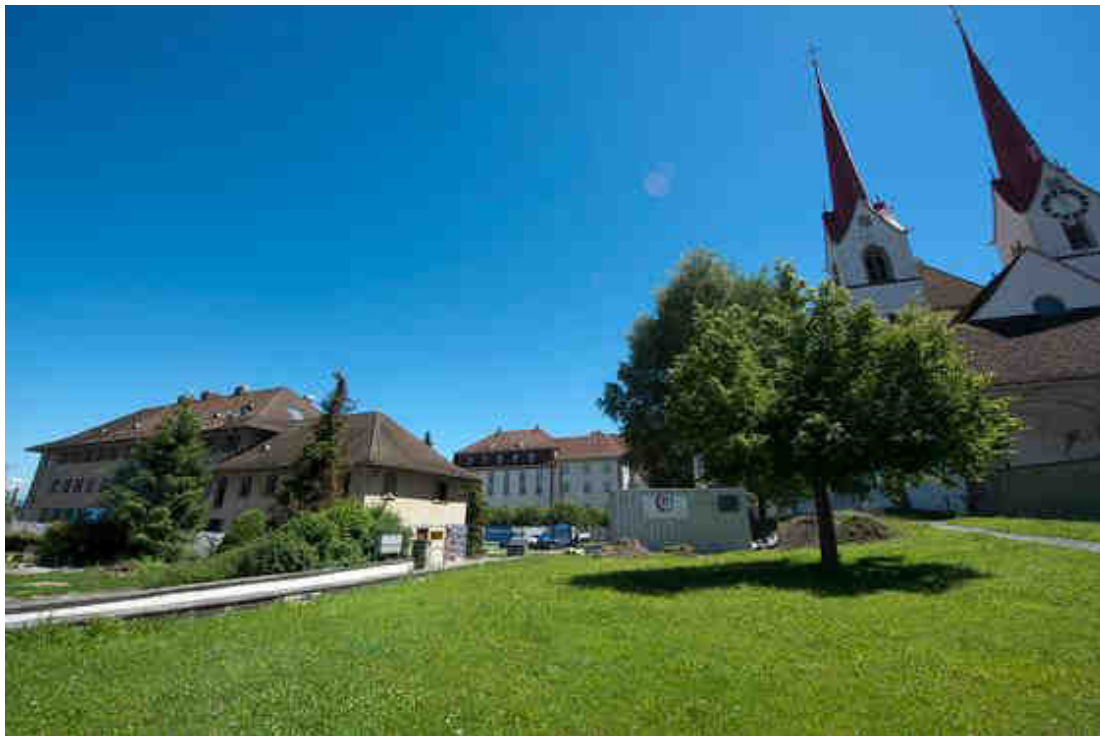
Die Pflegimuri wird abgerissen. (Bild: Maria Schmid (Muri, 22. Juni 2016))
