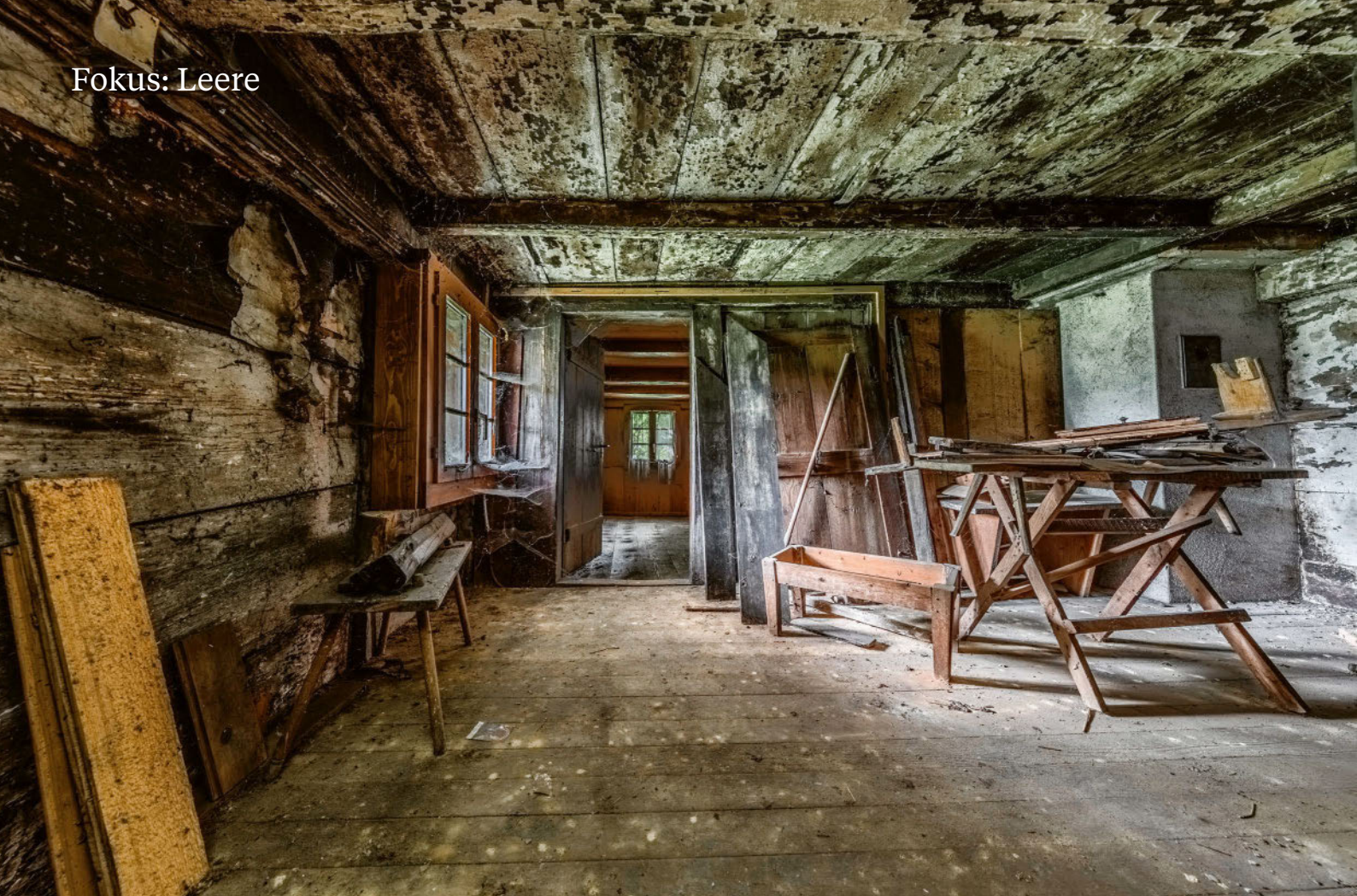
Seit die letzte Bewohnerin 2007 verstorben ist, steht das um 1700 erbaute Bauernhaus leer. Ein Teil der Scheune dient noch als Lager.
